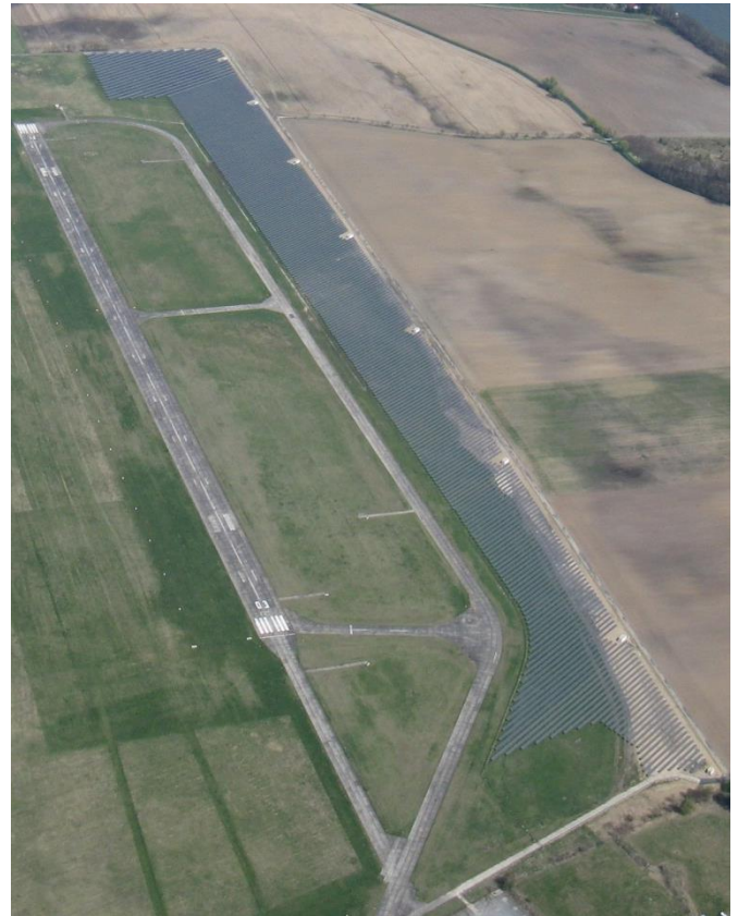
Abbildung 1: Luftaufnahme der Photovoltaikanlage
