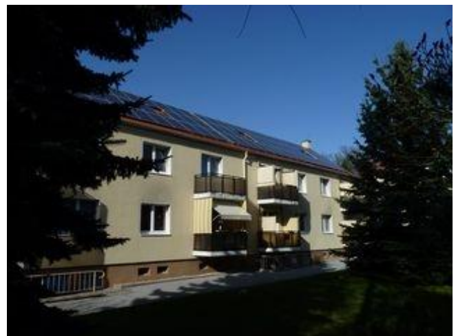
Abbildung 2: Bürgersolaranlage auf dem Dach des kommunalen Mehrfamilienhauses
