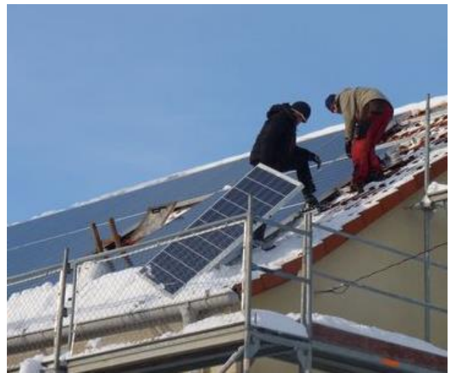
Abbildung 1: Montage der Photovoltaikmodule
